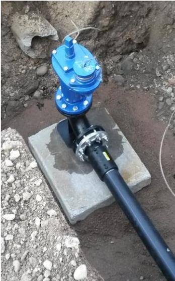
Siamo partiti con gli scavi a servizio della rete antincendio interrata, ampliando un anello esistente. Sono stati installati vari idranti sottosuolo.
