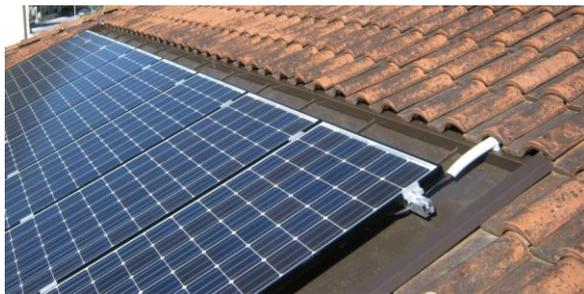
Dovendo lavorare su un tetto obsoleto, sotto l'impianto fotovoltaico abbiamo realizzato una "Vasca" in lamiera aggraffata di alluminio, ideale sia per la tenuta alle intemperie che per la resistenza al fuoco in caso d'incendio.
