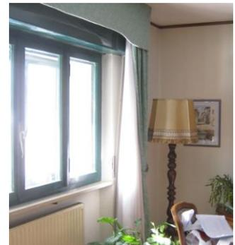
Abbiamo sostituito i vecchi serramenti con nuovi prodotti a triplo vetro, in legno interno e alluminio esterno. Abbiamo eliminato i cassonetti interni e installato persiane elettriche esterne in alluminio, complete di zanzariere.
