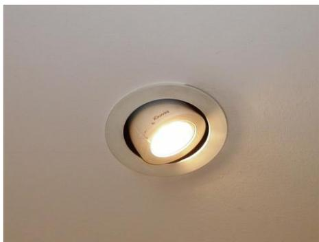
Sono state sostituite tutte le lampade dicroiche da 50 watt con lampade a Led ad alta efficienza, dotate di una giusta gradazione luminosa, che oltre a non alterare i colori, non sbiadiscono i tessuti dei capi d'abbigliamento.
